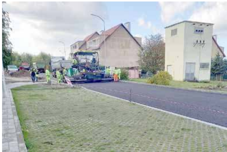
Efekty prac są już widoczne
