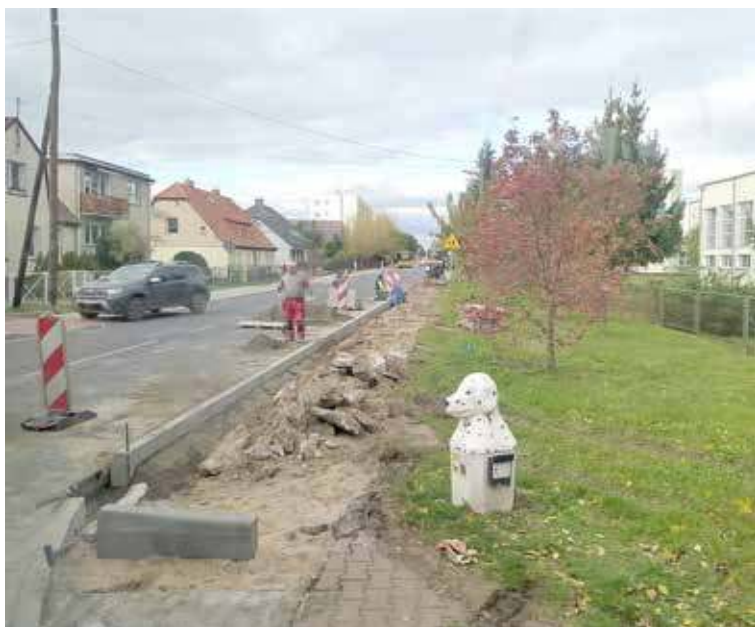
Już ponad dwa tygodnie temu rozpoczęły się prace po drugiej stronie ciągu pieszego
