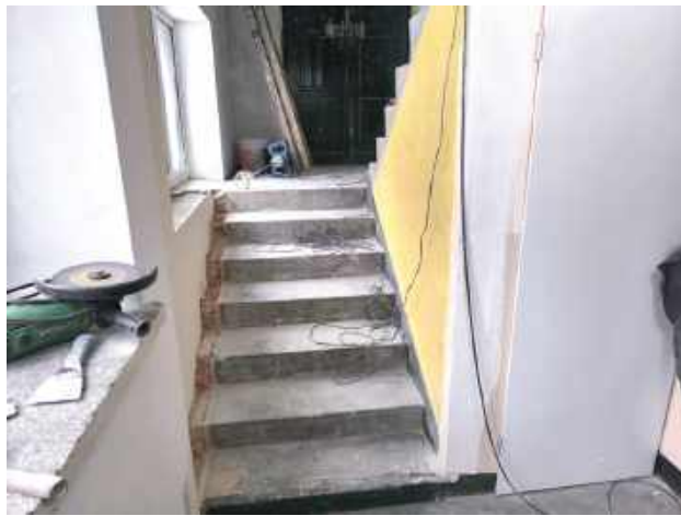
Konieczny był m.in. remont klatki schodowej
