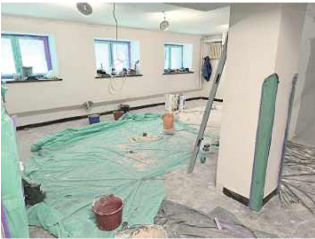
Prace remontowe wewnątrz szkoły prowadzone są zgodnie z harmonogramem, a ich efekty mają być widoczne w nadchodzących tygodniach, zgodnie z zaplanowanymi terminami realizacji
