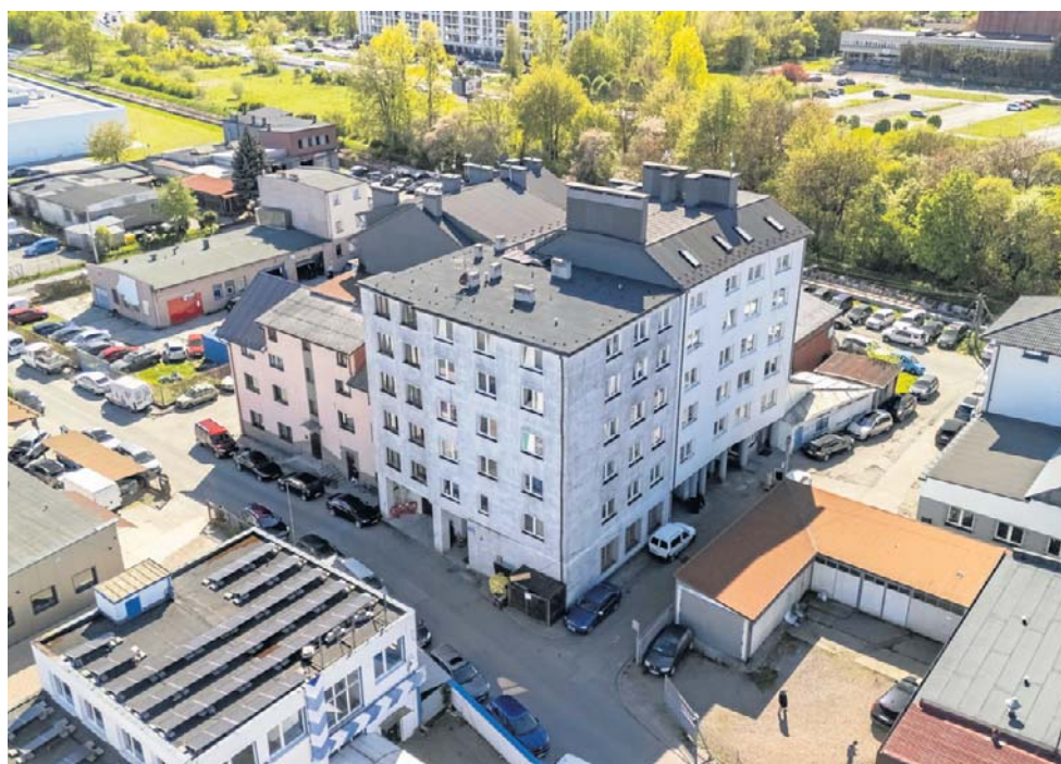
Na przeszkodzie w rozbiórce budynku przy ul. Centralnej 73B stanęły duże koszty prac
