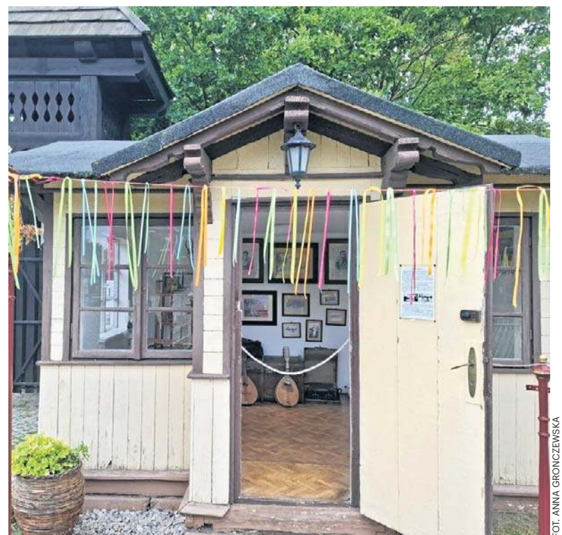
Budynek toalety stał pierwotnie w lasach spalskich
