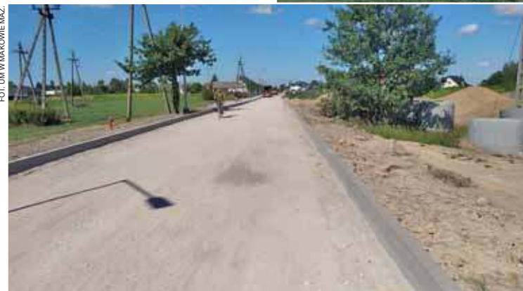
W mieście prowadzone są także remonty dróg
