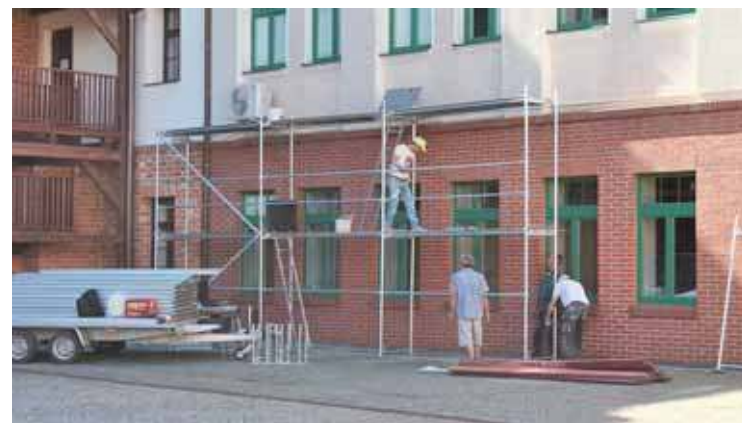
Roboty remontowe budynku Urzędu Miasta
