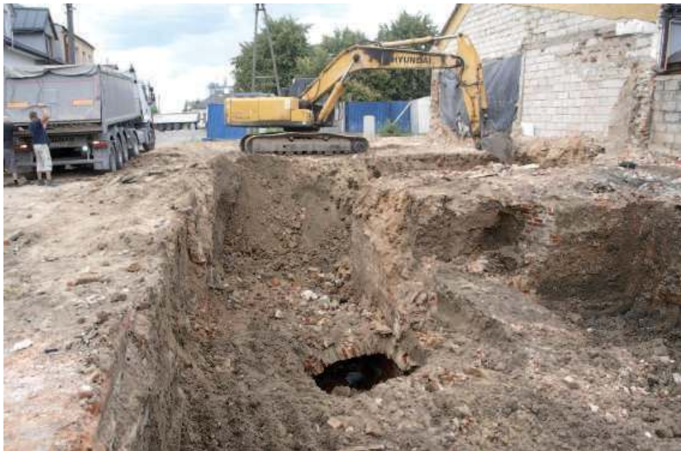
Drugi poziom piwnic pod zburzoną kamienicą na Rynku II - inwestycja prowadzona jest w południowo-wschodnim narożu placu rynkowego, gdzie z Rynku II wychodzi w kierunku wschodnim ulica łącząca rynek z ul. Partyzancką oraz Krótką
