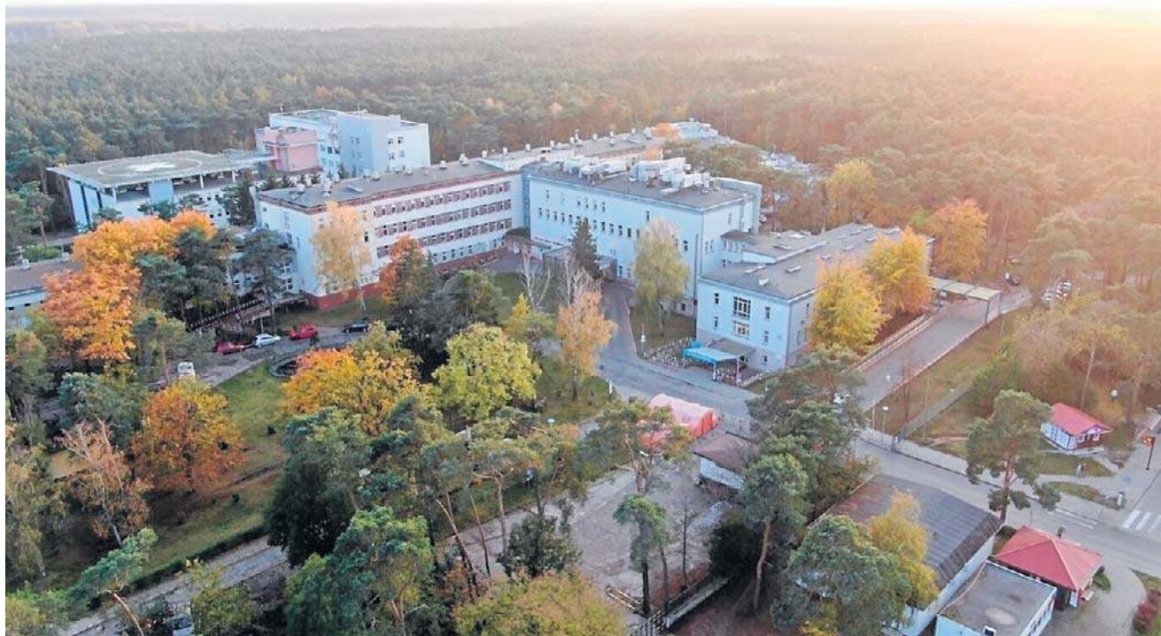
Szpital Specjalistyczny we Włocławku powstał w latach 1953-1963. Obecny widok
