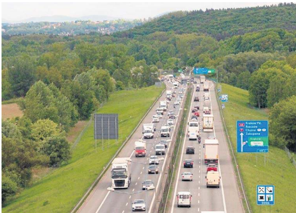
Rozbudowa obwodnicy Krakowa jest niezbędna – z tym wszyscy się zgadzają
