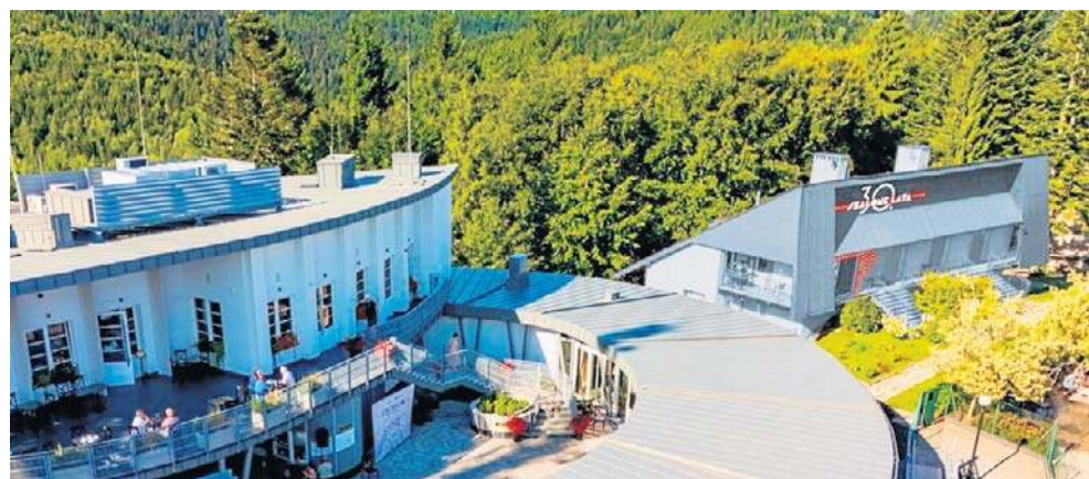
Trwają prace na Górze Parkowej. Nowa atrakcja was zaskoczy
