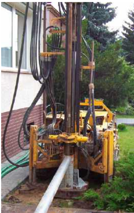
❏ Odwiert pod wymiennik pionowy. NIBE-BIAWAR
