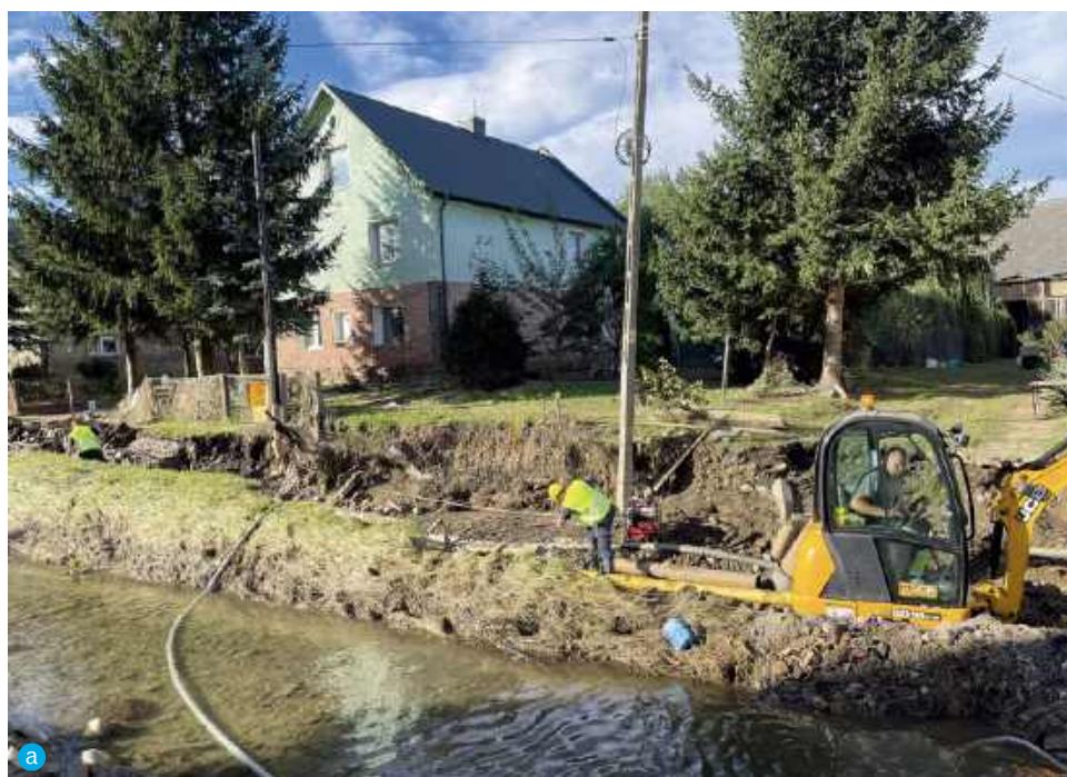
❶ Ekipa Polskiej Spółki Gazownictwa w trakcie pracy nad przywróceniem dostaw gazu w gminie Głuchołazy. Obciążanie gazociągu wymytego przez wodę (a) i montaż nowej skrzynki gazowej (b) – poprzednią zabrała woda. POLSKA SPÓŁKA GAZOWNICTWA
