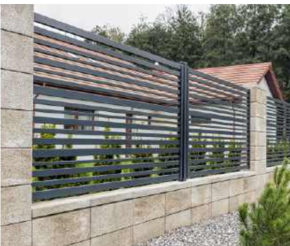
📍 Modułowe ogrodzenia stalowe bardzo często łączy się z niską podmurówką i słupkami wykonanymi z bloczków betonowych imitujących kamień. JONIEC
