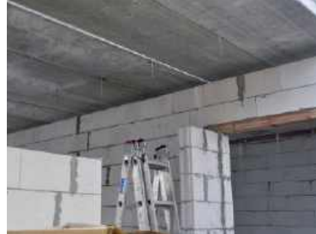
Stropy panelowe nie są narażone na klawiszowanie, czyli uginanie się pod obciążeniem pojedynczych elementów. STROPY.PL
