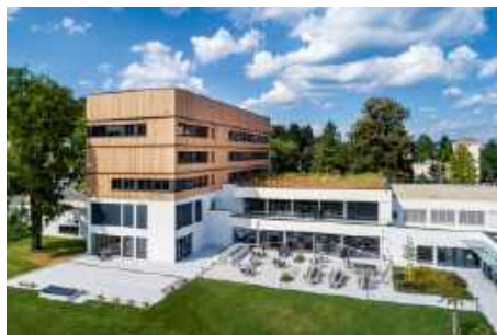
Stropodach zielony stanowi powierzchnię biologicznie czynną. BMI ICOPAL, T. RYBARCZYK
