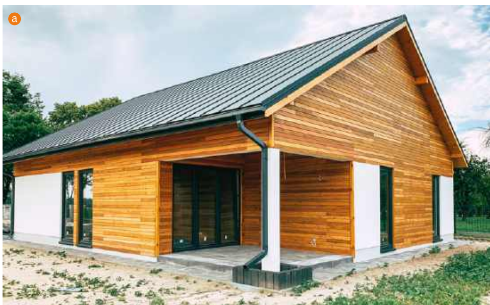
📍 Drewniana oblicówka to także nawiązanie do materiału konstrukcyjnego (a BUDMAN HOUSE). Ale elewacja domu z prefabrykatu drewnianego może być wykończona w dowolny sposób, np. płaską blachą i spiekami (b NORTHHOUSE).
