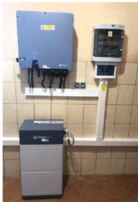
Falownik typu hybrydowego oferuje równocześnie funkcje obu pozostałych rodzajów. SOLPLANET /GROSUN
