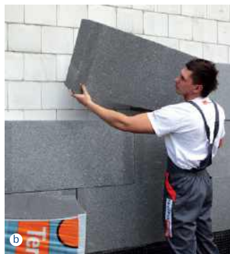
W ocieplaniu ścian systemem ETICS stosuje się wełnę mineralną (a ROCKWOOL) lub styropian (b TERMO ORGANIKA)
