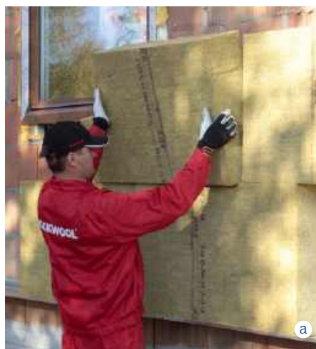
W ocieplaniu ścian systemem ETICS stosuje się wełnę mineralną (a ROCKWOOL) lub styropian (b TERMO ORGANIKA)
