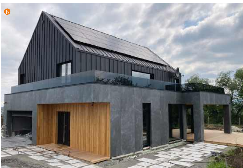
📍 Drewniana oblicówka to także nawiązanie do materiału konstrukcyjnego (a BUDMAN HOUSE). Ale elewacja domu z prefabrykatu drewnianego może być wykończona w dowolny sposób, np. płaską blachą i spiekami (b NORTHHOUSE).
