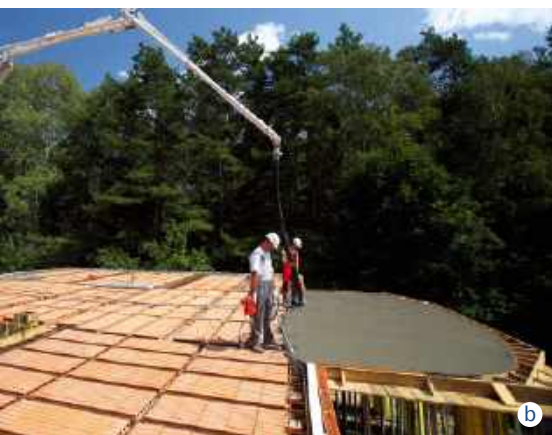
❶ Układanie ceramicznych pustaków w stropie gęstożebrowym (a) i zalewanie przegrody gotową mieszką betonową podawaną pompą (b).
