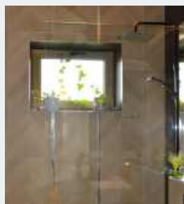
🔴 W czterech łazienkach, jest natrysk z natynkową termostatyczną baterią, deszczownicą i słuchawką prysznicową.
