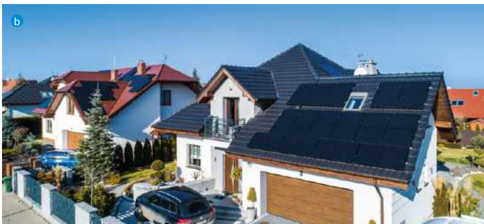
📍 Własny prąd z instalacji fotowoltaicznej pozwala na znaczne obniżenie kosztów ogrzewania pompą ciepła. a CREATON POLSKA, b COLUMBUS ENERGY
