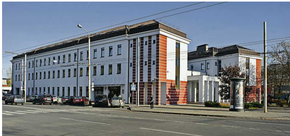
• Dom Kultury Polskiej w Wilnie rozbudowano dzięki dotacji z budżetu państwa m.in. po to, żeby powstało w nim studio telewizyjne oraz hotel i restauracja
