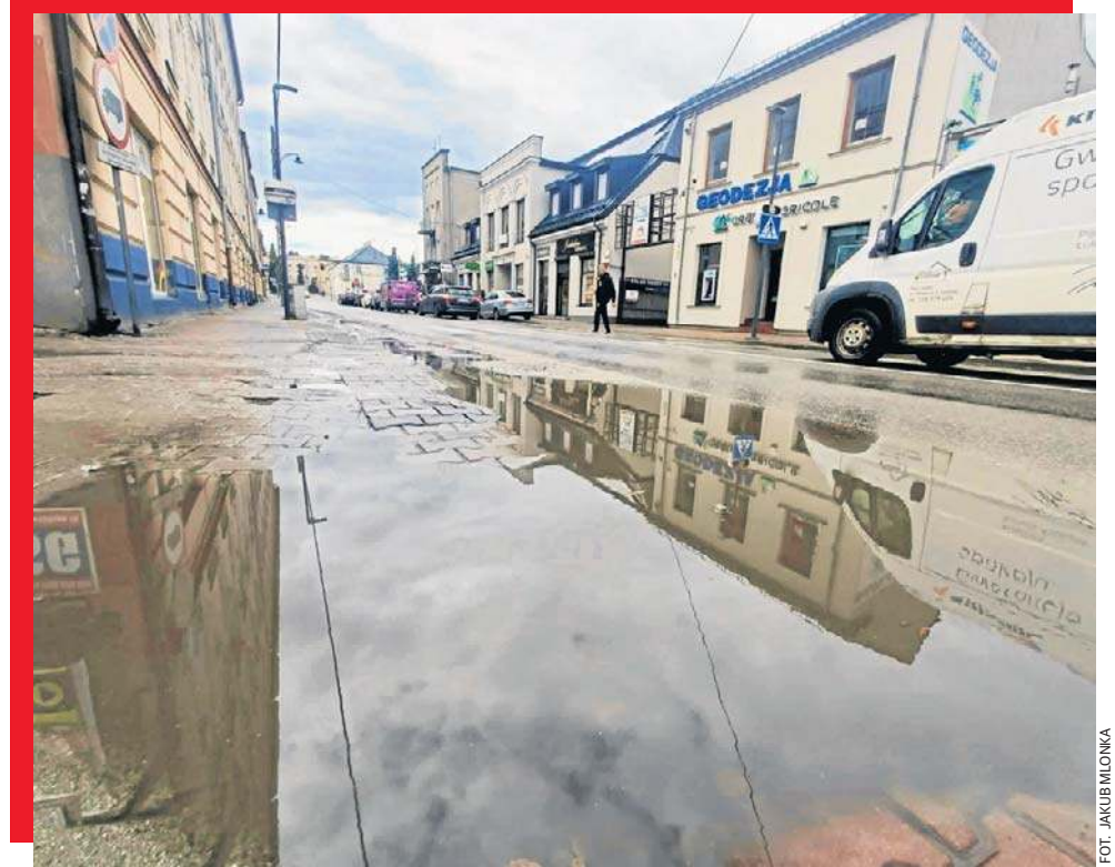
Ulica Długa w Zgierzu od lat jest zalewana.
