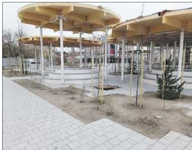
Zakończenie prac, związanych z rewitalizacją tzw. babskiego rynku, zaplanowano na koniec kwietnia
