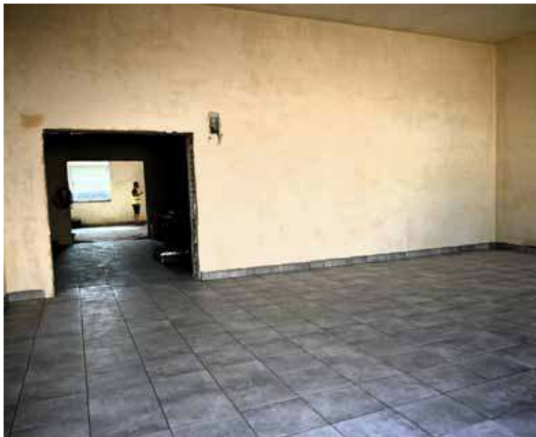
Obecnie trwają prace remontowe, tak by za kilka miesięcy siedem hal było gotowych do przyjęcia lokalnego biznesu
