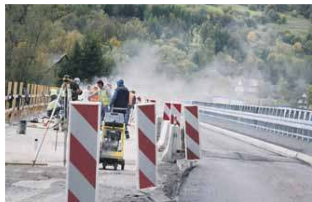
Zakończenie prac na moście w Ochotnicy Dolnej planowane jest na listopad.
