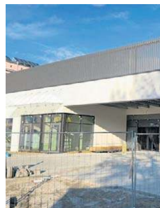
Plac budowy Szpitalnego Oddziału Ratunkowego.
