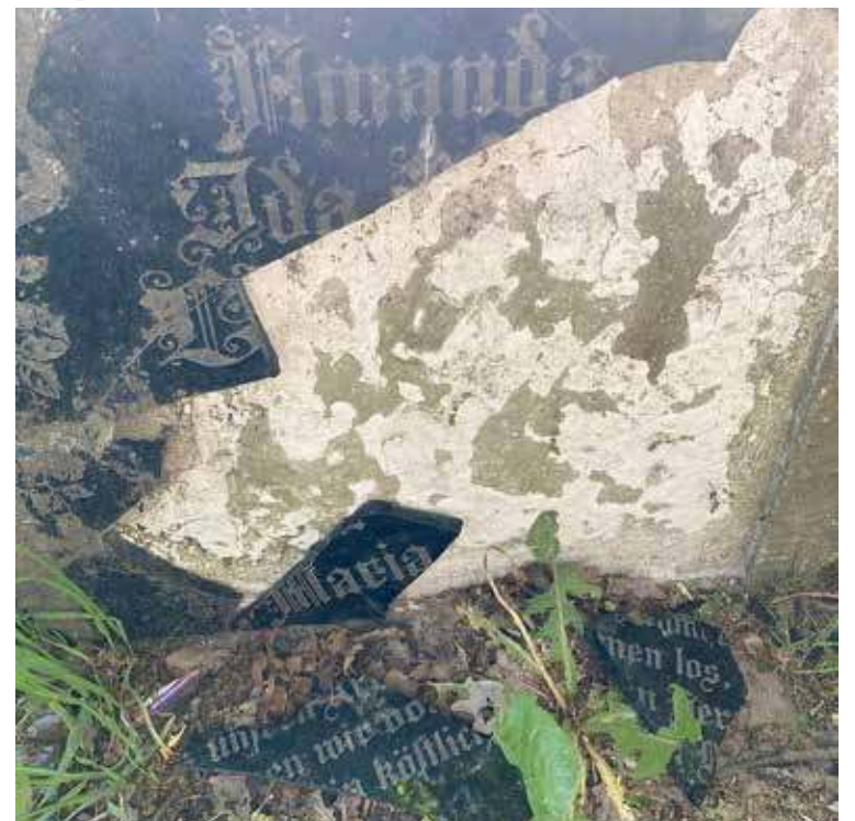
Uszkodzona płyt są znaczne
