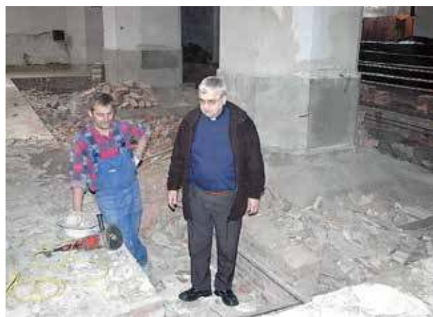
2006 - trwa odbudowa po pożarze
