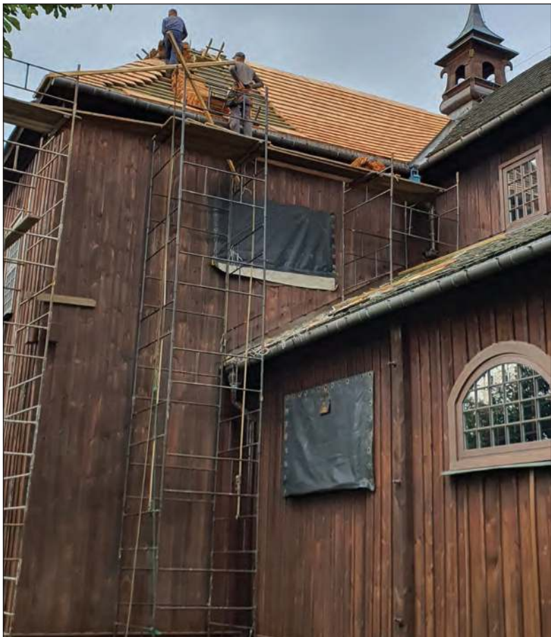
Na czas wymiany dachu okna zabezpieczono grubą plandeką
