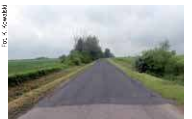
Nowo położona nakładka asfaltowa zakryła największe dziury
