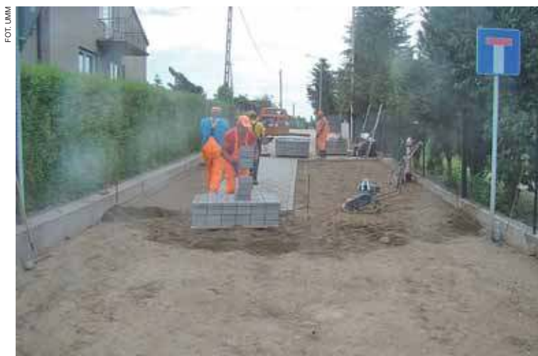
Remont ul. Krajewskiego
