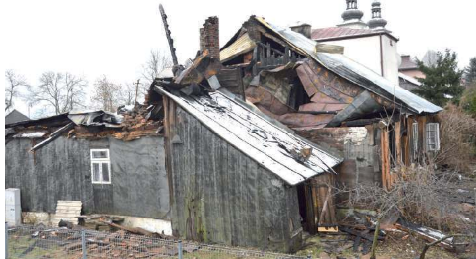
Spalił się dach, zawalił strop, wypaliło wyposażenie
