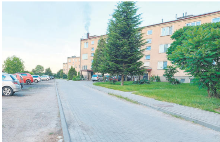
W spółdzielczej kotłowni znów grzeje się wodę.
