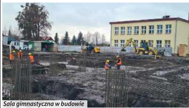
Sala gimnastyczna w budowie
