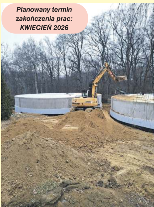
Stacja uzdatniania wody w Machnicach
