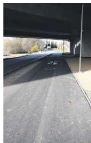
Nowa nawierzchnia drogi powiatowej
