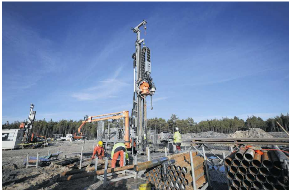
• Badania geologiczne na terenie przeznaczonym pod budowę pierwszej w Polsce elektrowni jądrowej FOT. MICHAŁ RYŃIAK / AGENCJA WYBORCZA.PL
