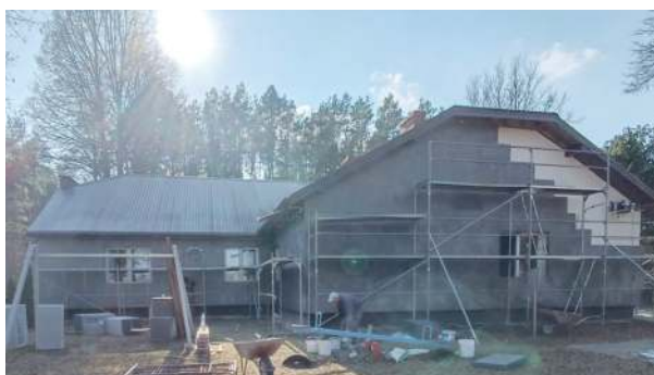
Budynek świetlicy w miejscowości Pościsz
