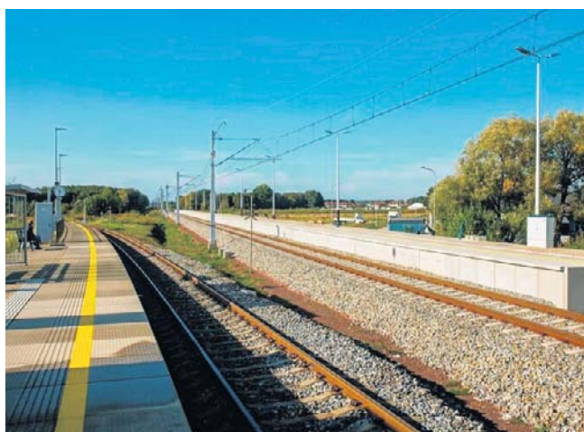
Nowa infrastruktura kolejowa w Kobylnicy.
