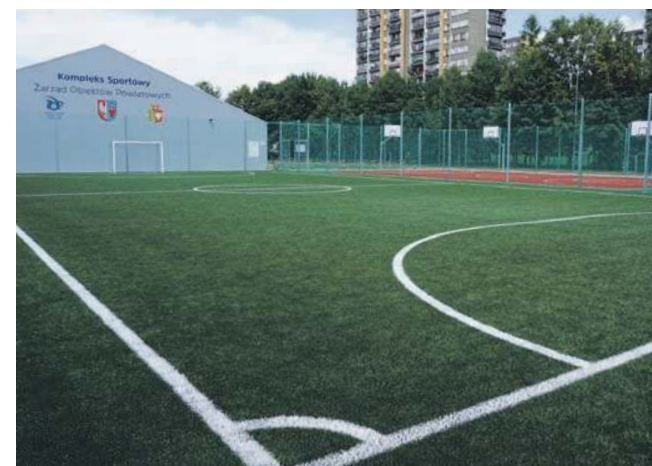
Kompleks Sportowy przy ul. Wyszyńskiego w Chrzanowie
