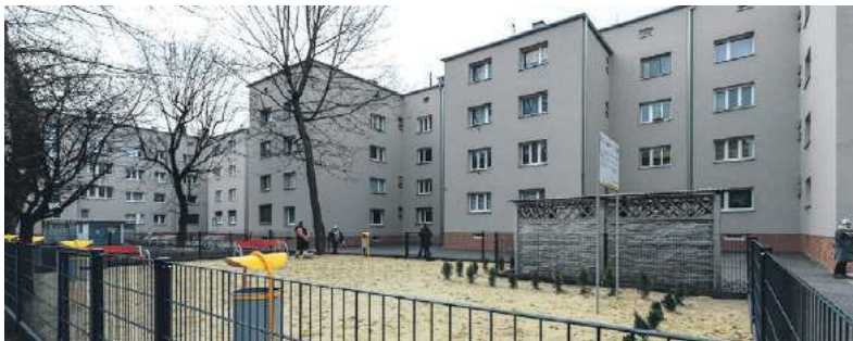
Rewitalizacja kamienic przy Głębokiej, Katowickiej i Matejki wyszła bardzo dobrze
