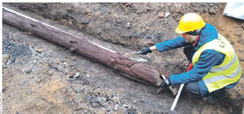
Ponad sto lat temu tą drewnianą rurą płynęła woda
