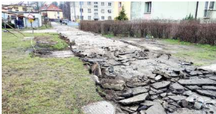
W Kluczewie rozpoczęła się duża inwestycja drogowa, w ramach której przebudowana zostanie ulica Kosmonautów, Lotników i część ulicy Lelewela
