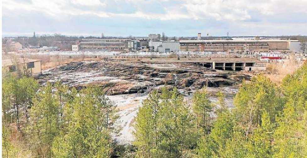
Wysoka zawartość zanieczyszczeń w wodach deszczowych spływających z hałdy stanowi realne zagrożenie dla środowiska
