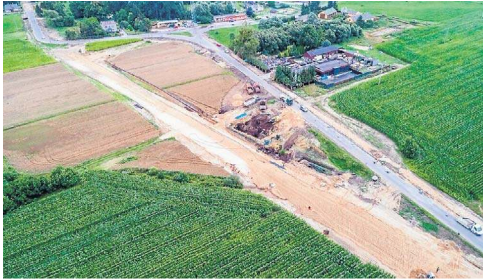
Prace na odcinku Stępowo-Okalewo-granica województwa zakończą się w przyszłym roku
