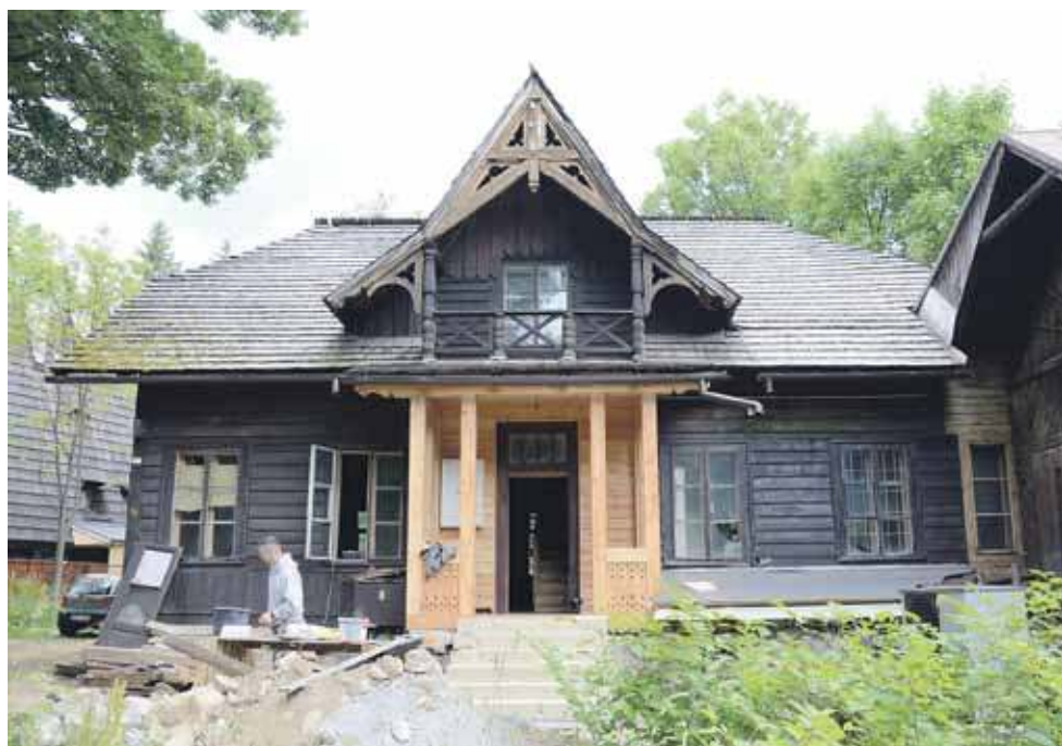
w Jadwiniówce trwa remont ganku.
