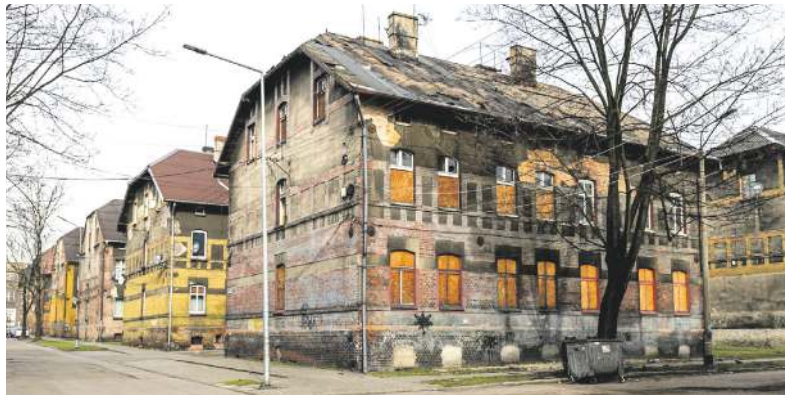
W ostatnich latach miasto wyremontowało między innymi budynki w Bobrku
