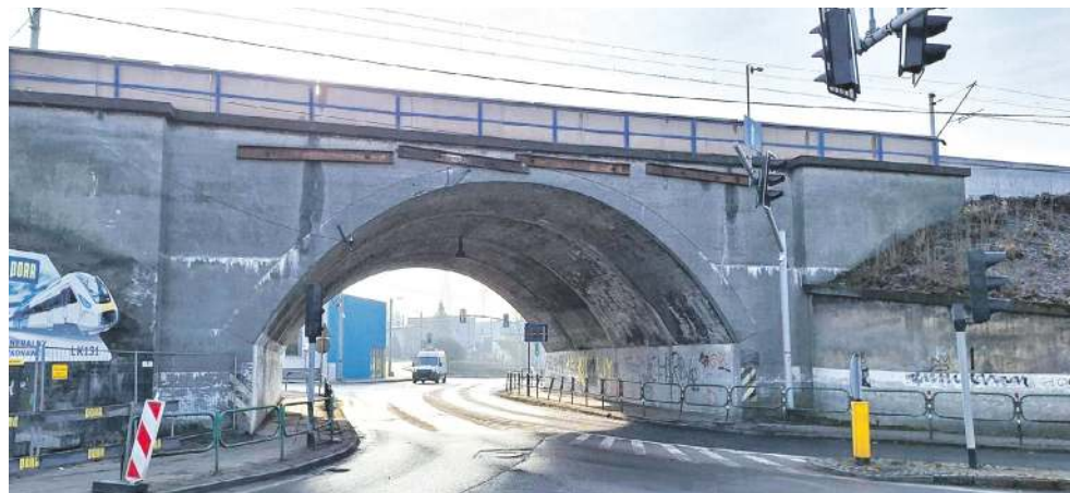
Stary wiadukt pomiędzy Radzionkowem a Rojcą to newralgiczne miejsce
