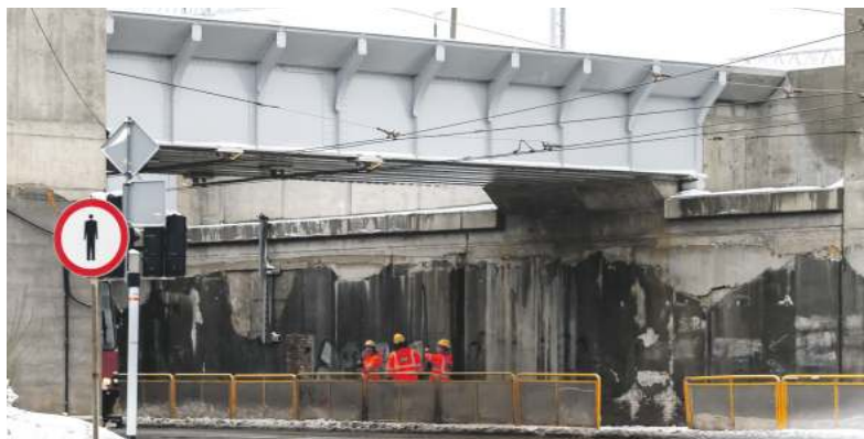
Wiadukt nabiera całkiem nowego wyglądu
