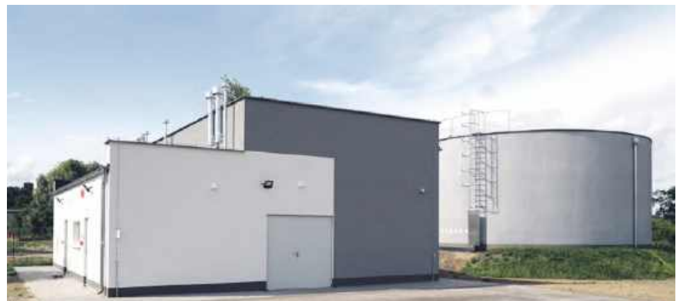
Stacja Uzdatniania Wody w Sobocisku
