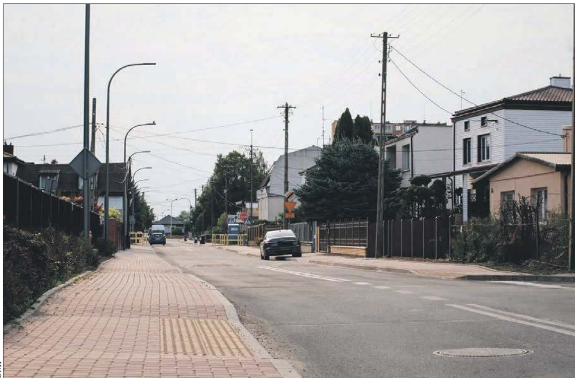
Przebudowana ul. Lasockiego w Płocku
