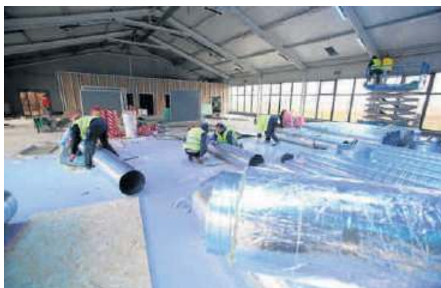
Trwa budowa szpitala tymczasowego przy ul. Rakietowej we Wrocławiu
