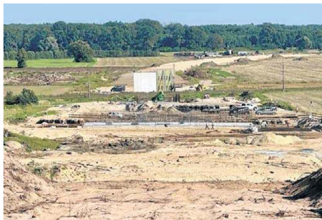
Nowy ślad drogi już widać
