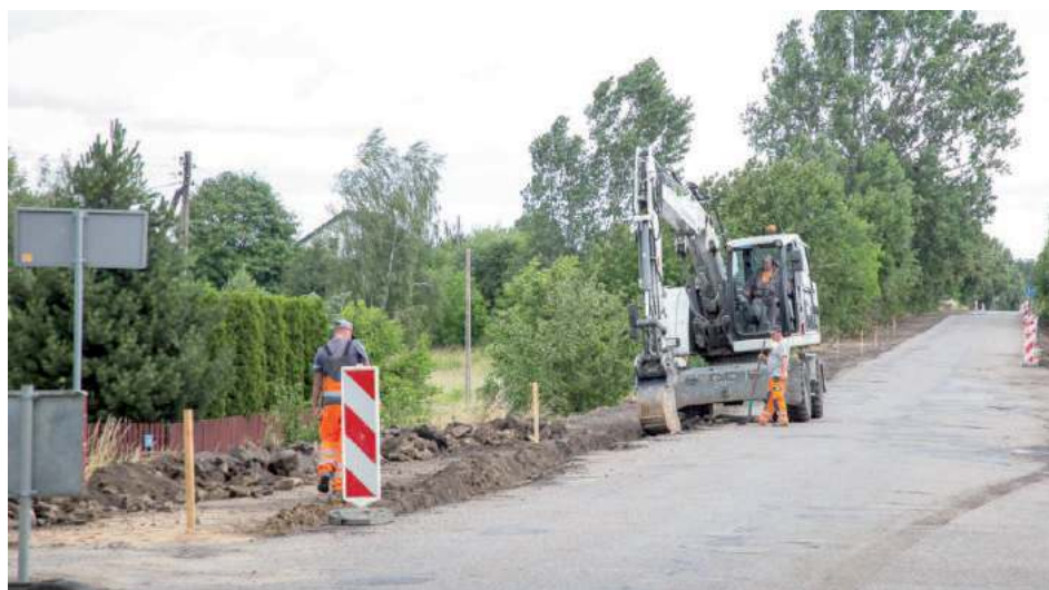
Trwa przebudowa ul. Kolejowej w Niemcach. Drogowcy wzmacniają konstrukcję jezdni na odcinku o długości 950 metrów oraz budują 650 m chodników, wraz z dwoma przejściami dla pieszych
