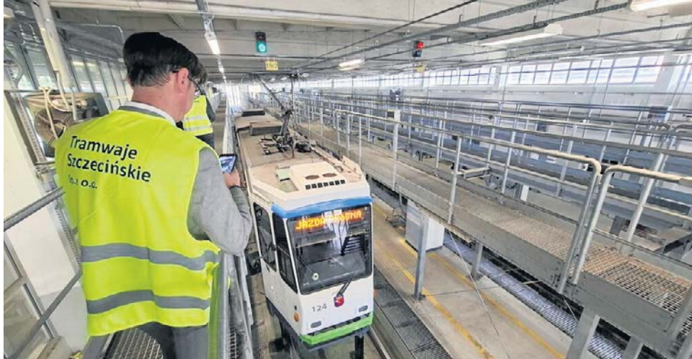
Zajezdnia Pogodno przeszła modernizację w 2015 roku. Będzie rozbudowa?
