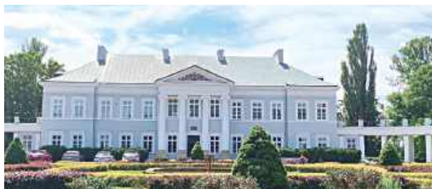
Pałac w Kocku po zakończeniu prac konserwatorskich
