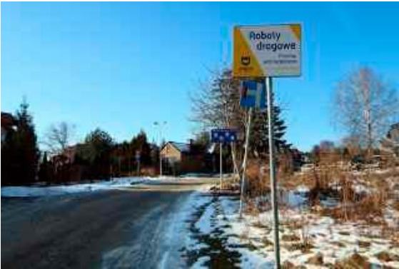
Prace ziemne na ul. Leszka mają rozpocząć się lada dzień
