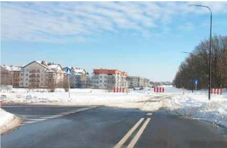
Jako pierwszy zostanie rozpisany przetarg na budowę ostatniego odcinka al. NSZZ „Solidarność”. Po jego wykonaniu zostanie domknięta mała, południowa obwodnica Świdnika
