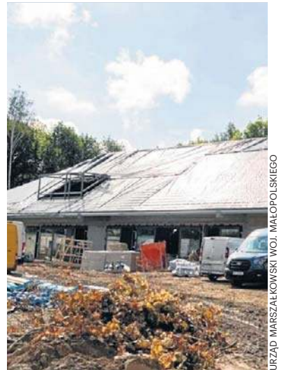
Trwają prace przy budowie centrum edukacji przyrodniczej
