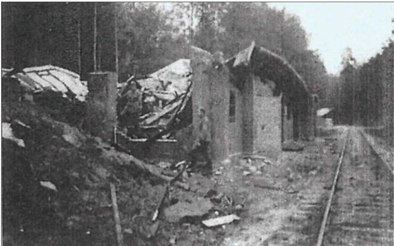
■ Składnica w Stawach nie uległa poważnym zniszczeniom. Po upadku kampanii wrześniowej przejęli ją Niemcy
