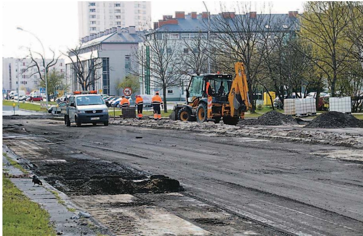
W pierwszym etapie przebudowy zamknięty dla ruchu został odcinek od skrzyżowania z Al. Jana Pawła II do skrzyżowania z ulicą Wolności
