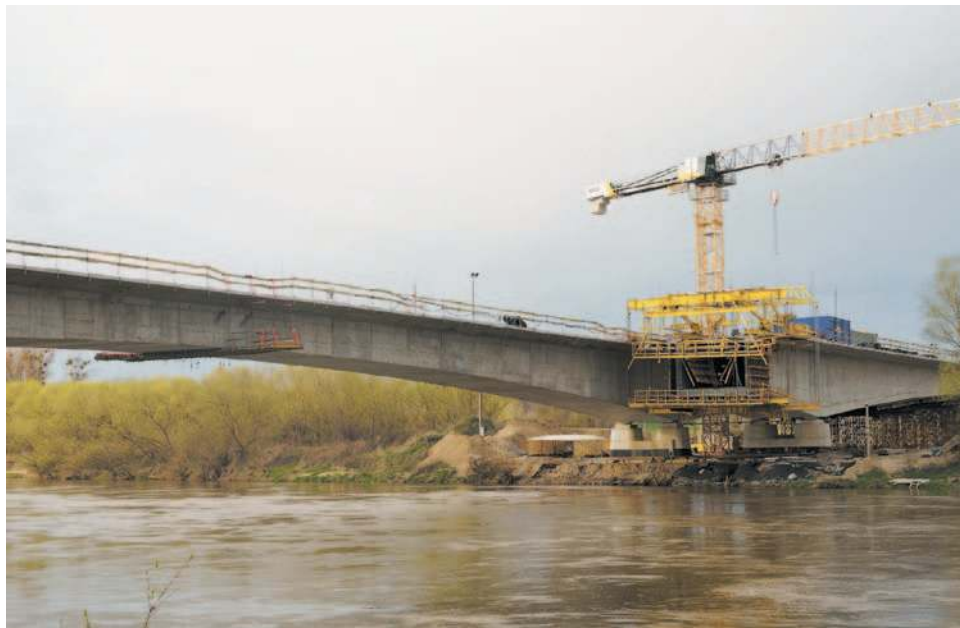
Budowa mostu na Sanie, na wysokości Nowej Wsi i Zarzecza
