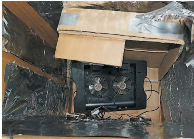
Urządzenia do uprawy konopi
