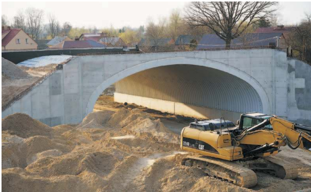
Dołem przebiegnie droga powiatowa Wolina – Nowa Wieś – Przędzel
