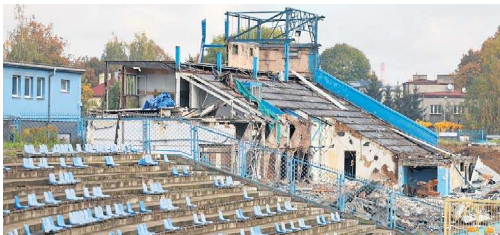
Trybuna główna stadionu już została rozebrana. Trwają prace przy budynku klubowym
