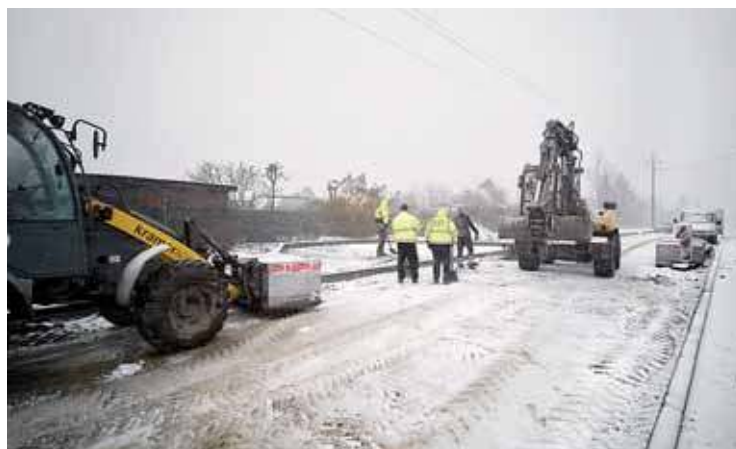
Modernizacja ul. Opinogórskiej w Ciechanowie
