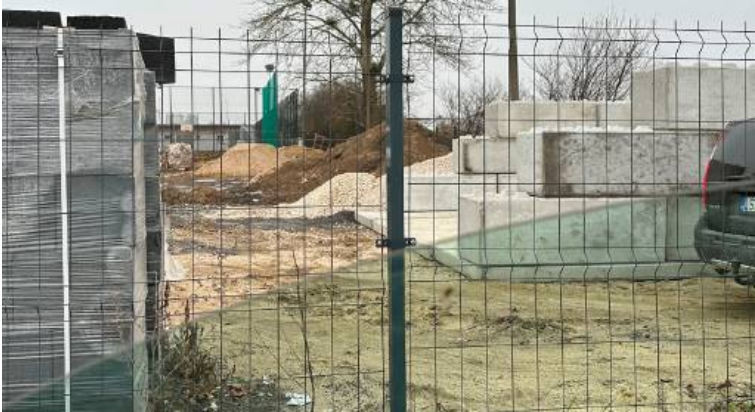
W Świdniku na potrzeby dotowanego węgla Pegimek wynajął kawałek nieużytku przy ul. Warsztatowej 5 i postawił niewielki, prowizoryczny silos
