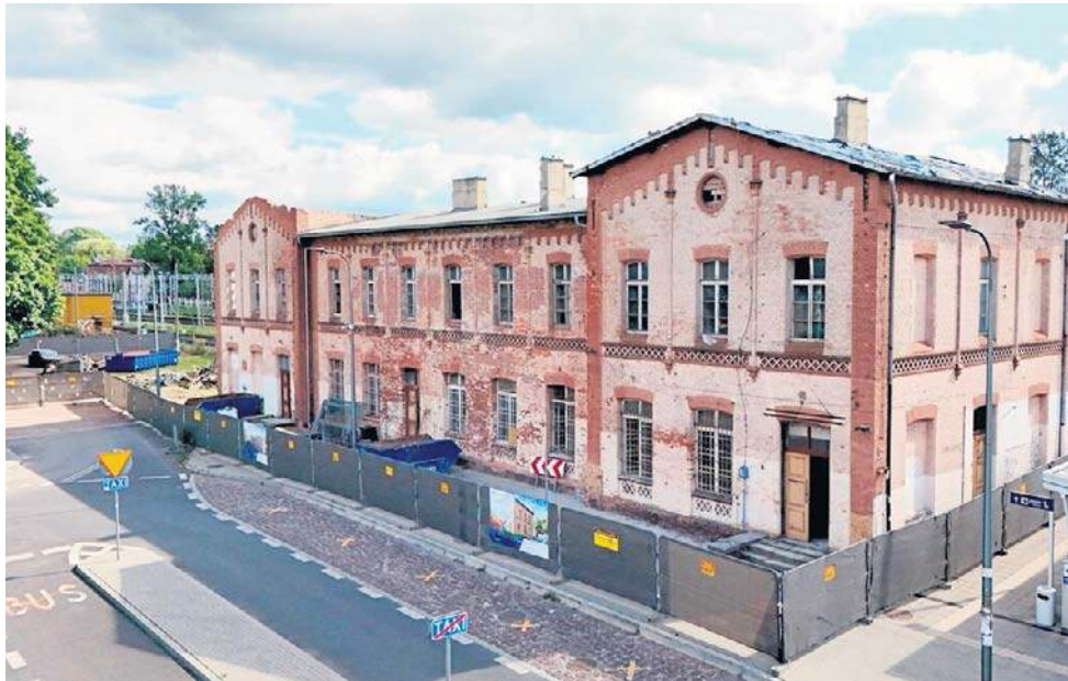
Gruntowna przebudowa dworca ruszyła latem w Dąbrowie Górniczej Ząbkowicach
