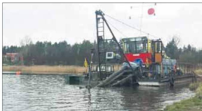
Zanieczyszczona woda jest wynikiem prac na Sosinie
